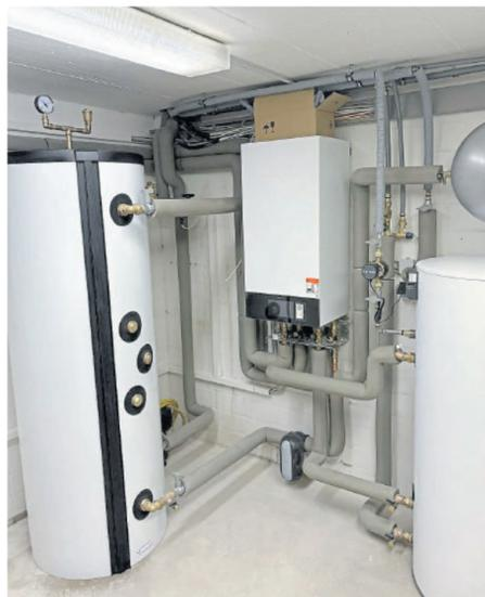
Umstellung einer Gasheizung auf Brennwertechnik mit einer Luft/Wasser-WP zur Warmwasserbereitung.
